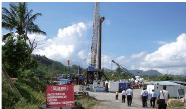
2005年、ラヘンドン地熱発電所3号機の建設に向け、蒸気を取り出す穴(地熱井)を2,000メートルの深さを超え掘削
