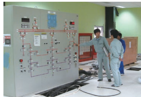
建設中のウルブル地熱発電所の中央制御室。左の装置は発電所や変電所の電源を管理する運転補助盤
