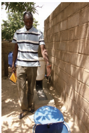
シャワー室の隣に設置された排水処理システム。排水を砂利に通すことで汚濁物が取り除かれ、農業用水などとして再利用できる
