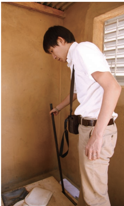
パイロットプロジェクトで使用しているコンポストトイレ。「用を足した後は、隣に設置されている棒でかき混ぜます」と伊藤助教。尿はペットボトルに詰めて屋根の上に置き消毒する
