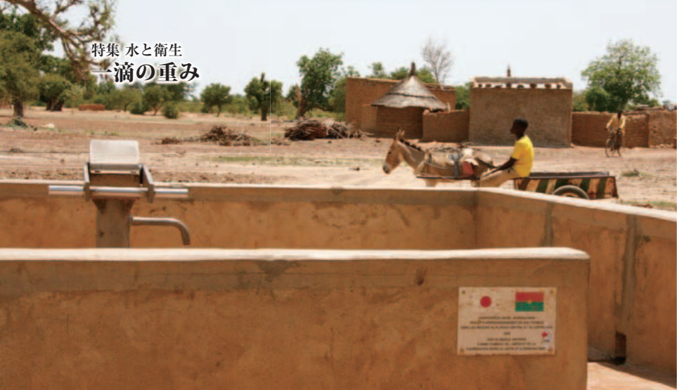
日本の協力で建設されたハンドポンプが付いた深井戸
