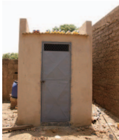
パイロットプロジェクトで使用しているコンポストトイレ。「用を足した後は、隣に設置されている棒でかき混ぜます」と伊藤助教。尿はペットボトルに詰めて屋根の上に置き消毒する
