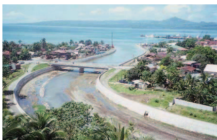
[左]洪水被害を抑えるため、マニラ首都圏を流れるパシグーマリキナ川の護岸改修を支援していく [右]レイテ島オルモック市でも洪水制御事業として護岸整備を実施
