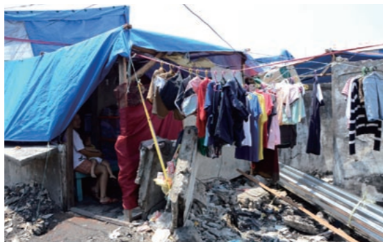
今でもスラム内には火事の残りがあふれ、屋根にもビニールシートがかけられている
