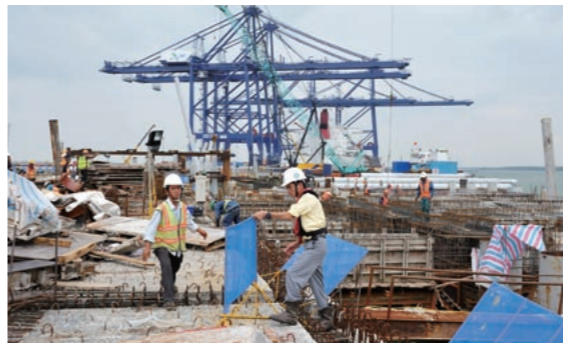
円借款で整備が進められているカイメップ・チンバイ港。港での輸出入手続きを迅速に進めるためにも、税関システムの改善と職員の能力強化が必要だ(撮影:佐藤浩治)
