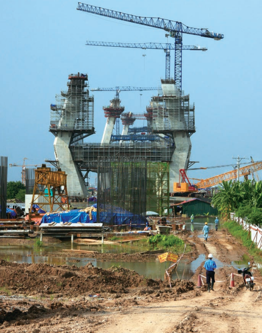
現在、建設が進められているハノイのニャタン橋。JICAは物流の促進や投資環境整備にとって重要なインフラ整備も積極的に支援している
