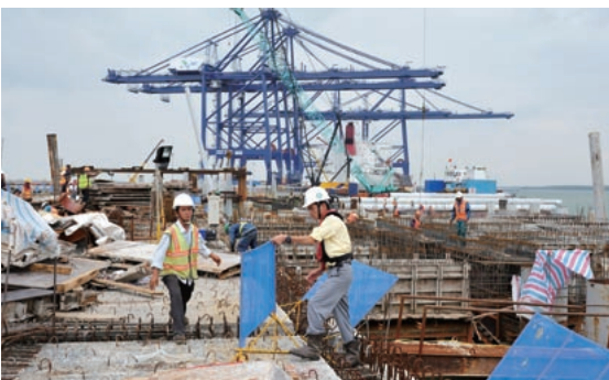
円借款で整備が進められているカイメップ・チューバイ港。港での輸出入手続きを迅速に進めるためにも、税関システムの改善と職員の能力強化が必要だ（撮影:佐藤浩治）
