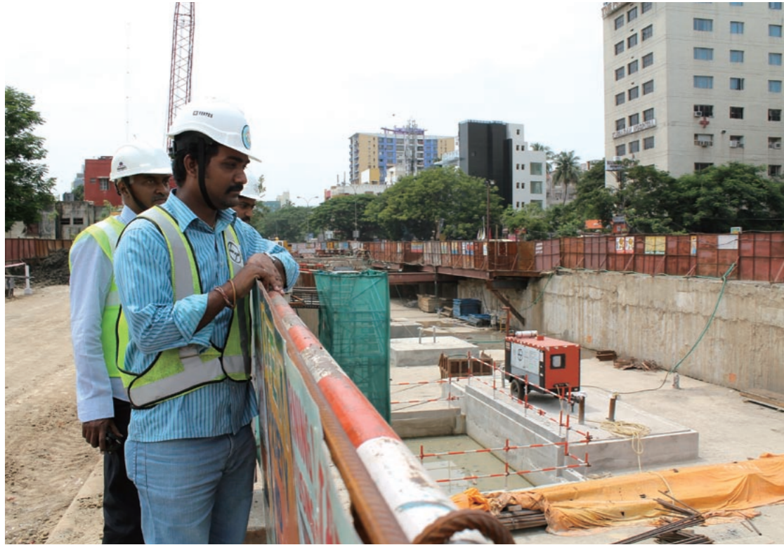
地下の駅となるネルーパークの工事現場。安全管理を促すポスターを張ることで、作業員の意識も高まってきた
