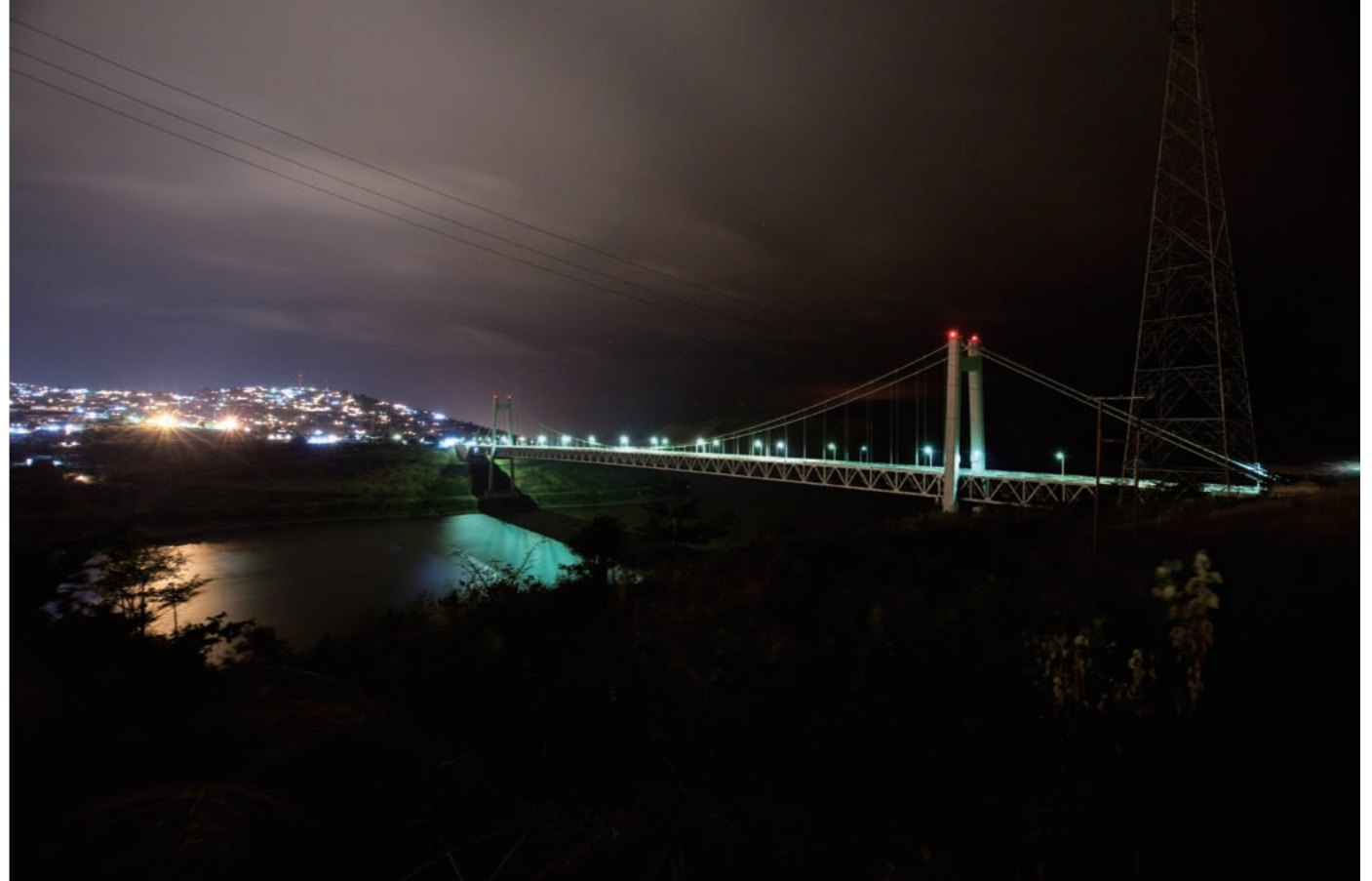
夜空に浮かぶマタディ橋。ライトアップされた姿は平和の灯にも見える
