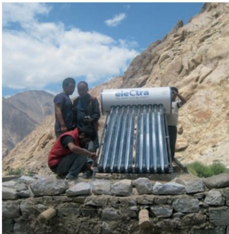
JICA基金で設置されたソーラーウォーターヒーター。太陽光で温められたガラスの管に水を流して温水にする
