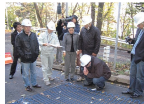
旭川市内の道路工事現場では、電気を通して雪を溶かすロードヒーティングの仕組みを見学
