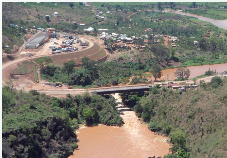
重い車両が通れるようになったルスモ橋と、併設された国境手続き施設。タンザニア・ルワンダ間の物流の可能性が格段に広がる
