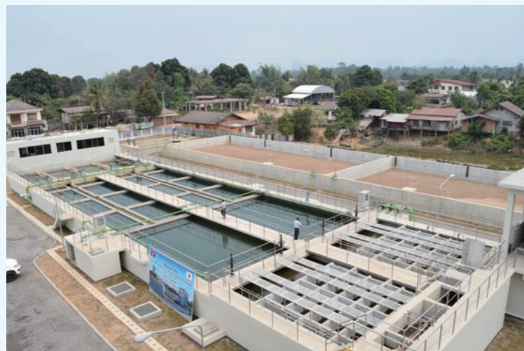
着工から3年かけてタケク郡に完成した新しい浄水場
