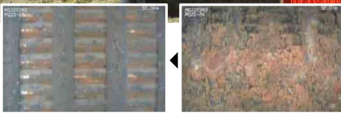
右：井戸の内部の壁面。経年劣化によってスクリーンが見えなくなるほど水垢や錆などがこびりついていた。左：洗浄後はスクリーンの表面がきれいになり、ふたたび井戸の内部に地下水が流れ込むようになった。調査では井戸の深度もわかるため、原因の発生場所の特定も容易だ。
