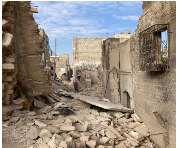
写真上： アレッポの町で崩壊した建物
