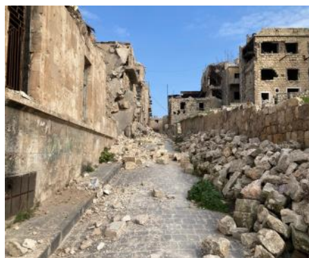
写真下 アレッポの町で崩壊した建物
