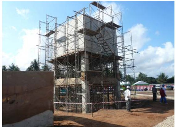
9月9日平成20年 キブグモ(テメケ県)での施工中の写真 高架タンク(60m 3 柱高さ5m)と制御室建設現場 コンクリート打設完了後 周りの資機材が片付けられ、整理整頓がなされている。
