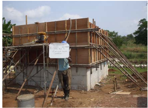
8月12日平成20年 キビンドゥ(バガモヨ県)での施工中の写真 制御室建設現場 型枠用サポートが施され崩壊に対し安全に施さ れている。
