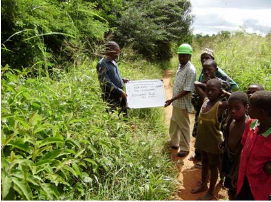
5月31日平成20年 キビンドゥ(バガモヨ県)での施工前の写真 高架タンク建設現場 村落内で一番高い場所での高架タンク建設で 村内の子供たちが期待感が高まり様子を見 に来た。
