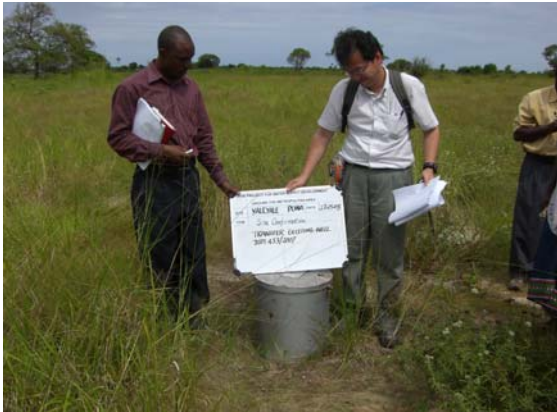
5月27日平成20年 ヤレヤレプナ(テメケ市)での施工前の写真 高架タンクと制御室建設現場 井戸引渡しで、村長ほか関係者との現場確認 草原で周りには何も無い。
