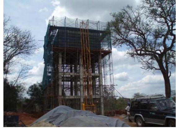
9月25日平成20年 キビンドゥ(バガモヨ県)での施工中の写真 高架タンク(100m 3 柱高さ10m)建設現場 転落防止の安全ネットが施され施工された。 工事用フェンスが施されているため、村民の侵 入がない。
