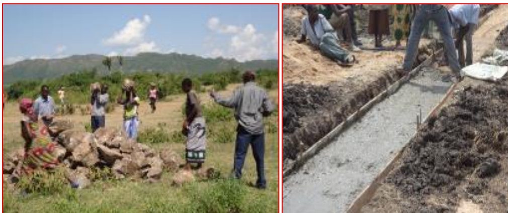
Ujenzi wa mifereji ya umwagiliaji
