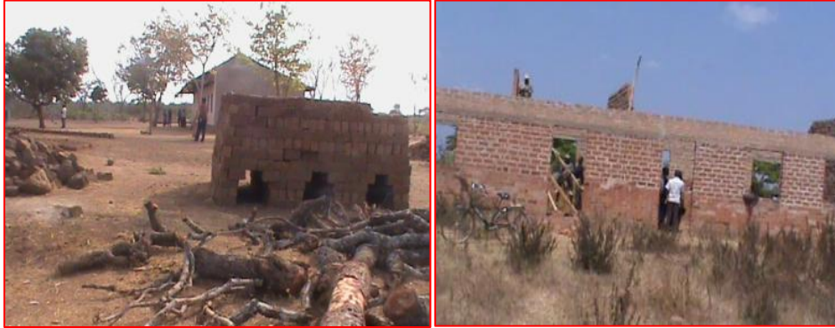
Uandaaji wa Matofali katika shule shikizi ya Imalamawazo – Butobela
