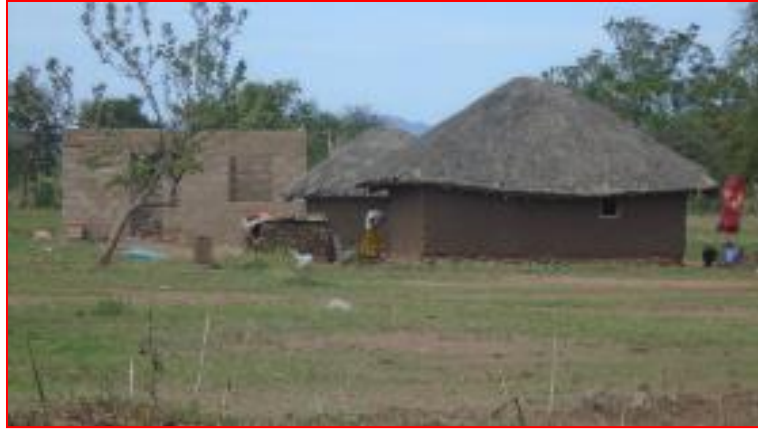
Nyumba ya zamani na ujenzi wa nyumba mpya ukiendelea
