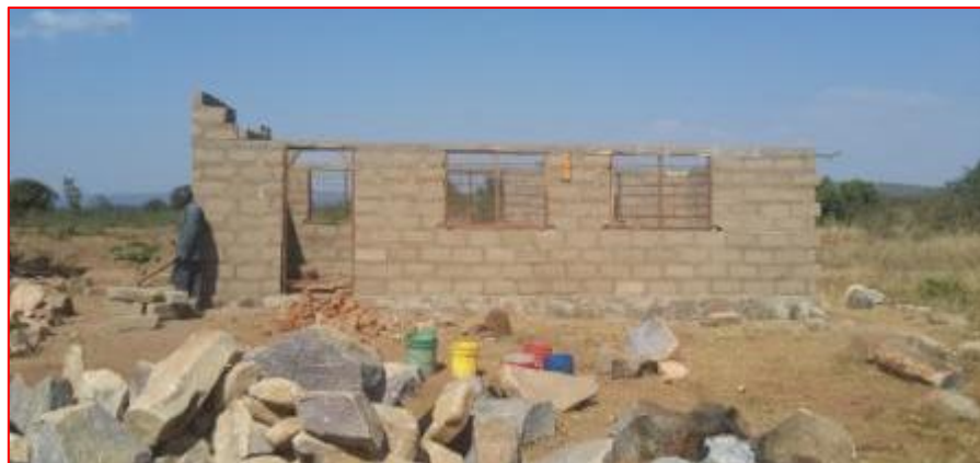
Vifaa vya ujenzi vilivyoletwa na jamii katika shule shikizi ya Dodoma Kata ya Kigongo
