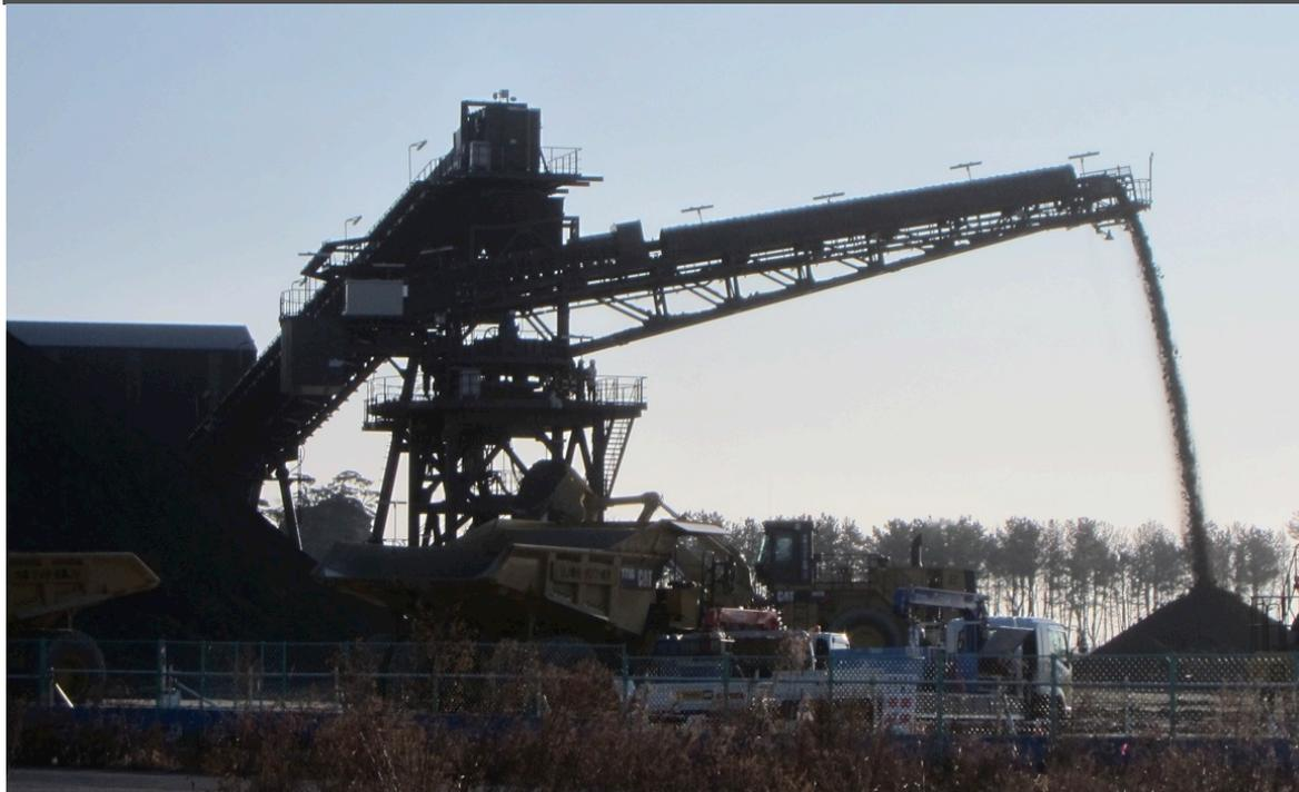
野蒜北部丘陵地区の宅地引き渡しをめざし、ベルトコンベヤが1月13日から始動した。大量の土砂を搬出するのに大型ダンプトラックだけで運ぶ場合3年以上かかる見通しのところを、ベルトコンベヤを利用することで造成工事期間を大幅に縮める計画が本格化した。(野蒜地区南余景で撮影)
