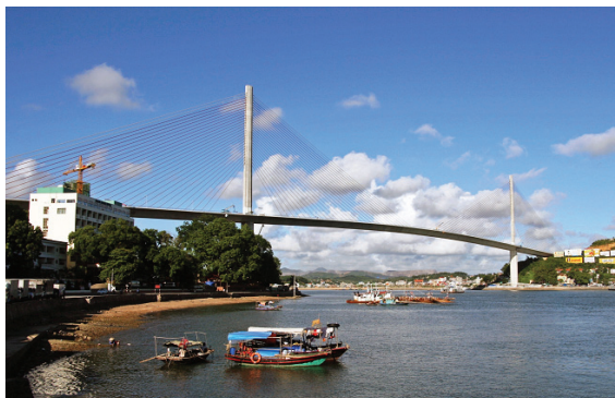
Cầu Bãi Cháy
