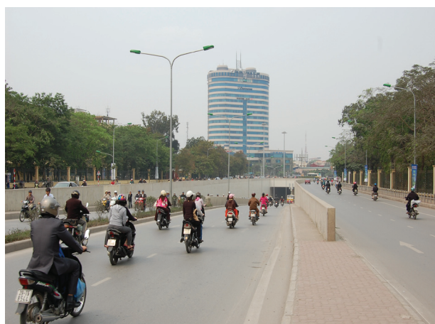
Kim Lien Underpass
