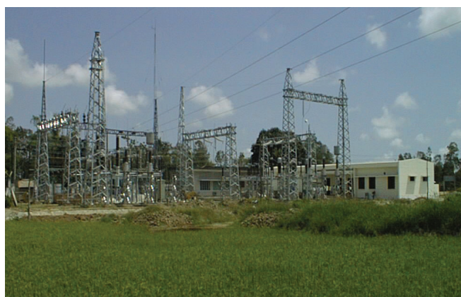
Đường dây tải điện 500KV Phú Mỹ - TP HCM
