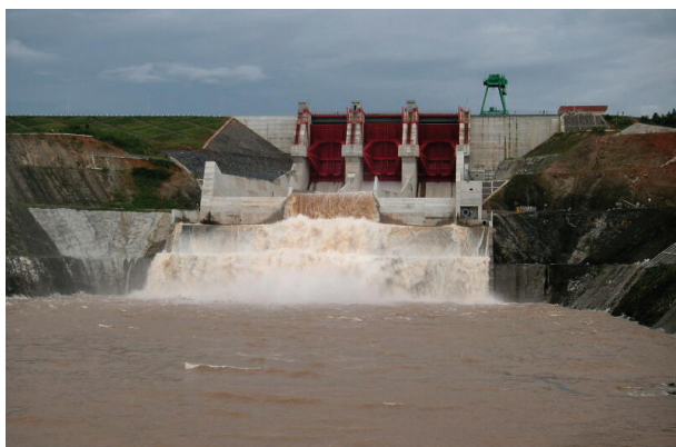
Nhà máy thủy điện Đại Ninh
