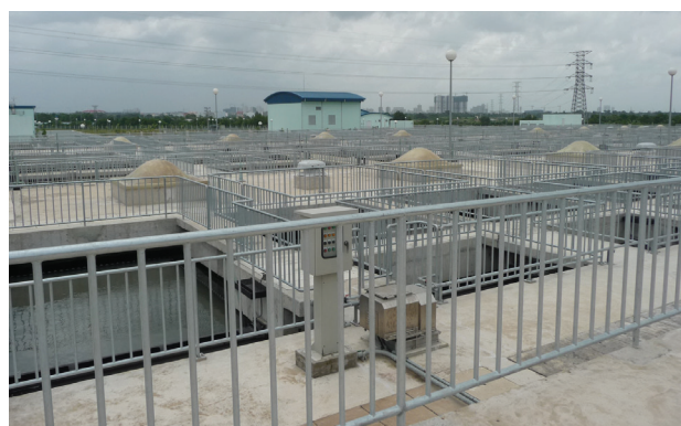
Cải thiện môi trường nước TP HCM (Nhà máy xử lý nước thải)
