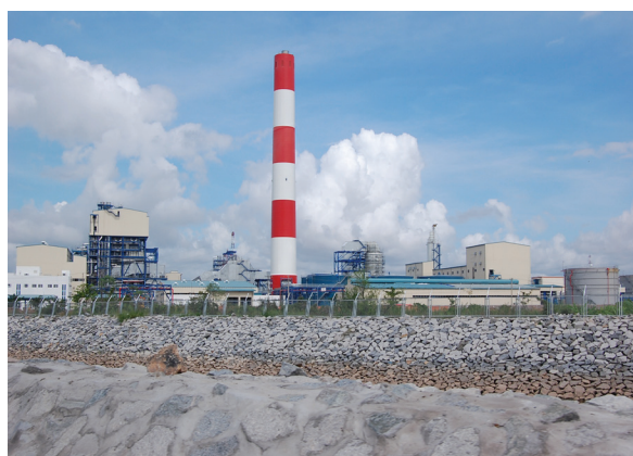
Nhà máy nhiệt điện Ô Môn
