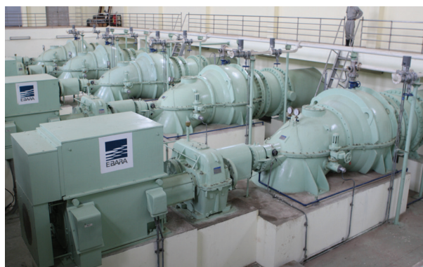
Trạm bơm Yên Sở
