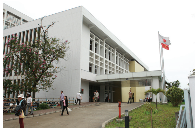
Nâng cấp cơ sở vật chất BV đa khoa tỉnh Hòa Bình (viện trợ không hoàn lại)
