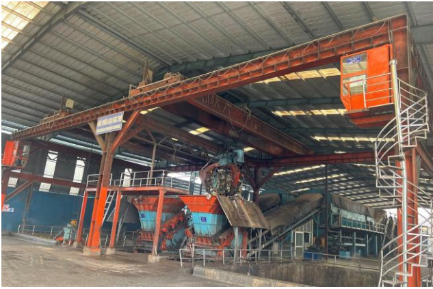
Nhà máy xử lý rác thải tại Bình Dương
