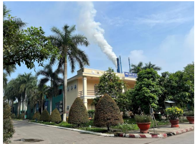
Nhà máy xử lý rác thải tại Bình Dương
