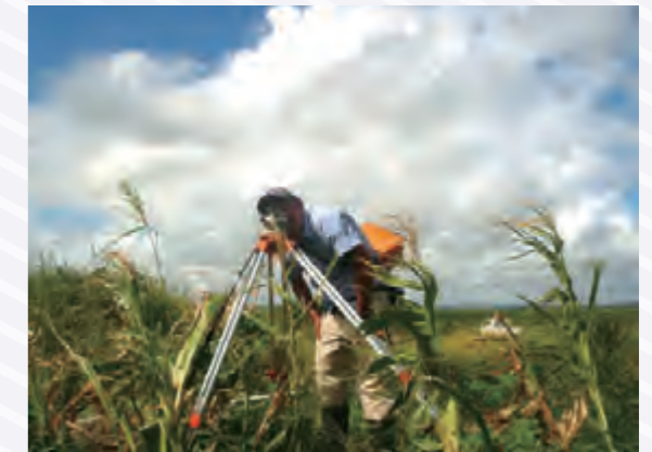
1万2千ha流域における幹線水路の測量
