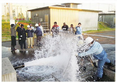
trainees africanos acompanham o trabalho de reparo de vazamentos num centro de treinamento em gestão da água.
