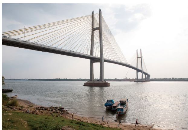
カンボジア「つばさ橋」が開通（ネアックルン橋梁建設計画）（無償資金協力） 2015年4月
