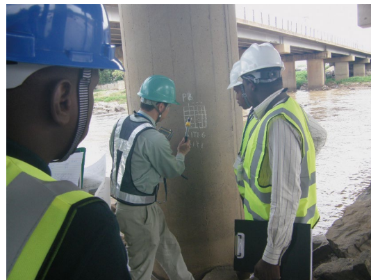
ナイジェリアの技術者に道路構造物の点検技術を紹介する日本企業の専門家（コンクリートテスター〈CTS〉を用いた道路付帯コンクリート構造物の点検技術の普及・実証事業）〈中小企業海外展開支援〉 2014年3月
