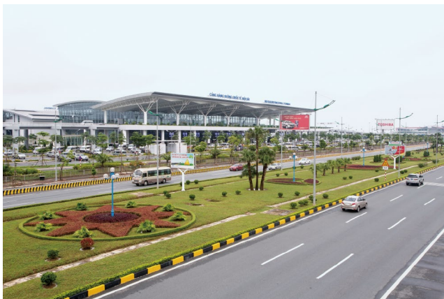
ベトナム・ノイバイ国際空港第二旅客ターミナルビルが運用開始（ノイバイ国際空港第二旅客ターミナルビル建設事業）〈有償資金協力〉 2014年12月
