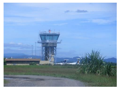
老朽化が進む管制塔
