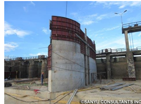
(写真左) 工事中の防潮水門（後ろ側が既存の水門） (写真右上) 既存の防潮水門。コンクリート、ゲート設備ともに劣化が激しい (写真右下) ほぼ改修が完了した支線水路
