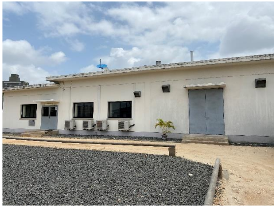
制御棟（イラ変電所）
