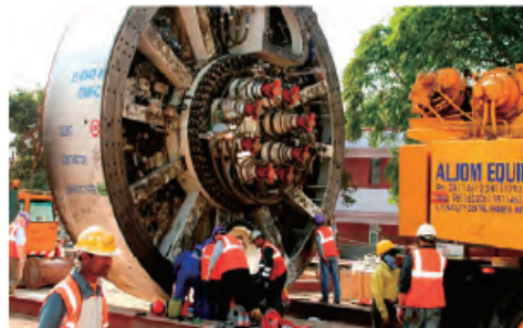
全断面トンネル掘削機の組み立て
