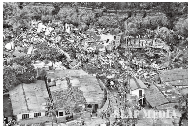
写真-2 崩壊後の周辺家屋の被災状況
