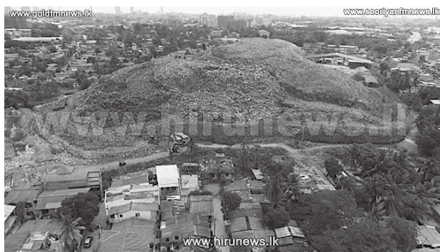
写真-1 崩落前のミートタムツラ処分場(2016年8月時点)
