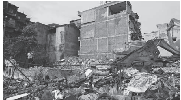
写真-2 建築解体現場 (ハノイ市)
