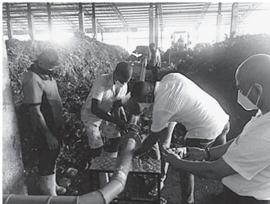
図-4 送風パイプの据え付け作業の様子
