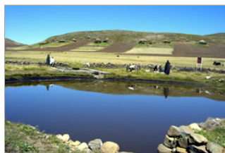
JICA 草の根技術協力事業で造成した溜池。粘土質の土を押し固めて造りました。
