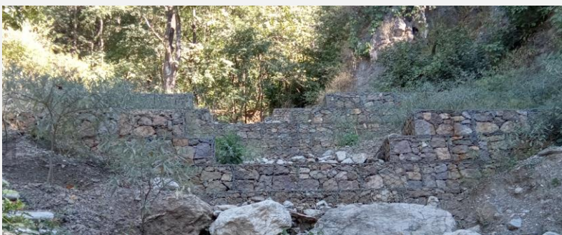
写真② 布団籠床固工（施工済）
