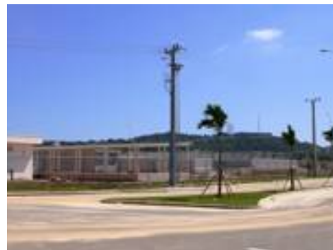
下水処理プラント。工場排水が垂れ流し にならないよう特区専用の施設を整備
