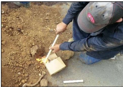
写真 1 火炙りによる PVC 管の接続作業
