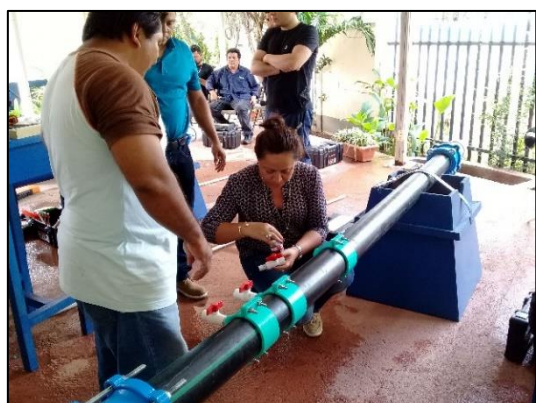
写真 3 分水栓の施工実習
