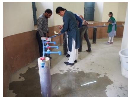
簡易な水道メーター検査室の建設
