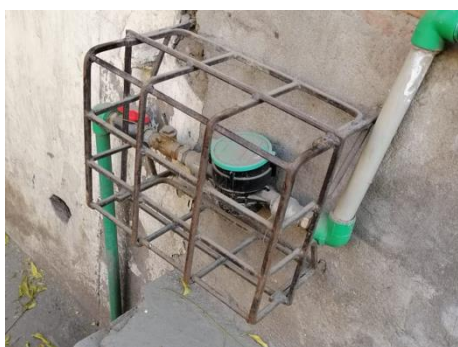
水道メーター設置状況
