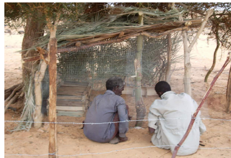
Commencer par fixer le grillage et mettre le barbelé ensuite
