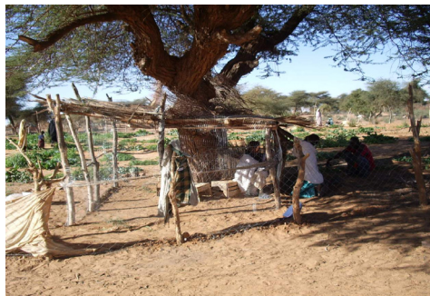
Commencer par fixer le grillage et mettre le barbelé ensuite
