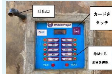
電子マネーを用いた 給水システム (鉦研工業株式会社)
