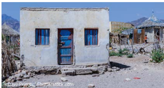
ジブチの建物にはエアコンが設置されていないことも少なくない。そのかわり、大きな窓には日ざしを避ける罌戸がつけられている。
