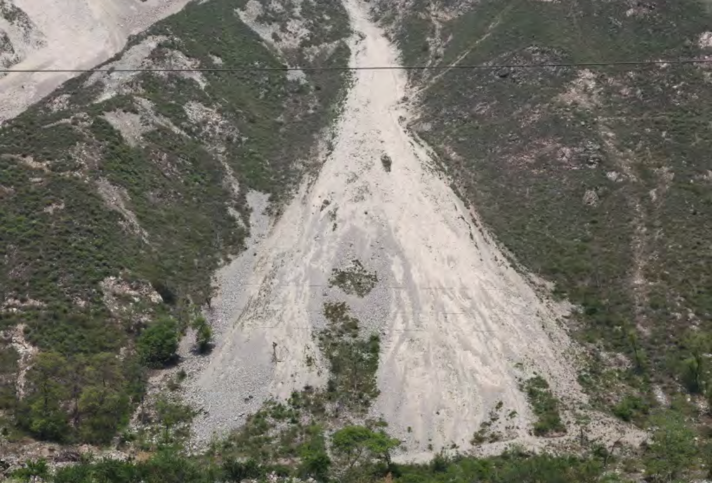
汶川地震灾后森林植被恢复项目（技术合作）（2） 摄于2011年5月施工前
