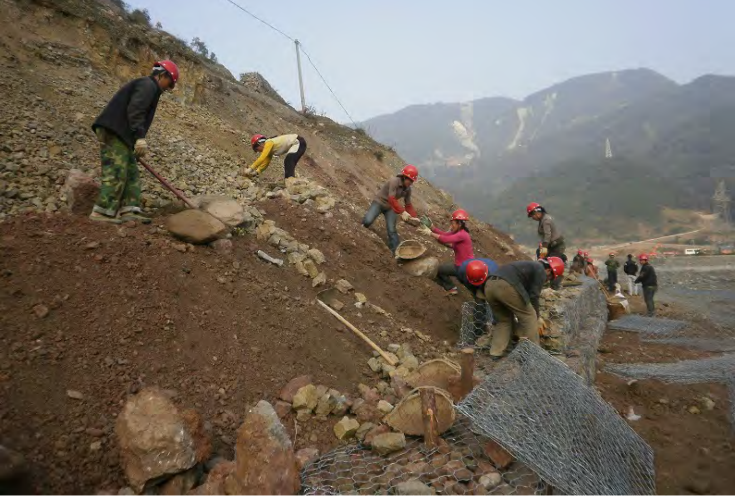
汶川地震灾后森林植被恢复项目（技术合作 2010年2月—2015年1月）（1） 项目开工
