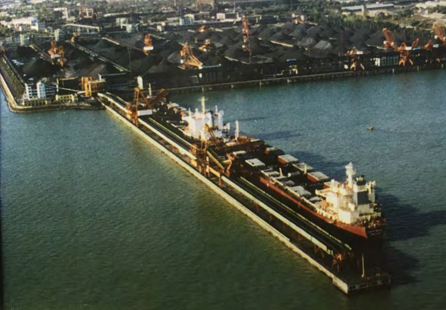
秦皇岛港煤炭码头二期工程（日元贷款 1979-1981年度）
