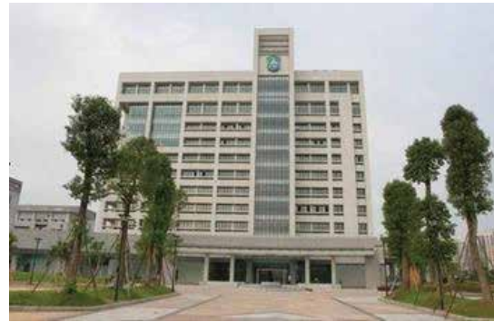
移転して新しくなった広州 CDC 外観
