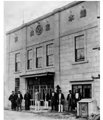
44. 関東大震災後新装された熊本屋旅館 1926年
