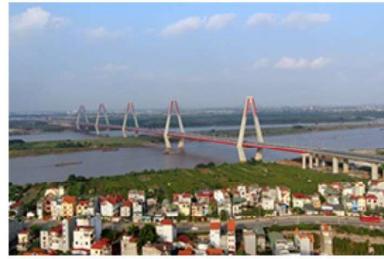
ニヤタン橋 (日越友好橋)
