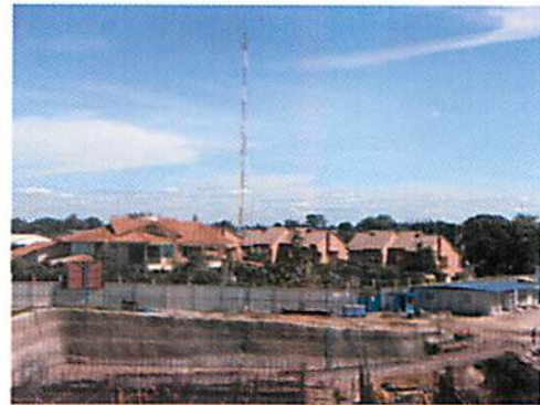
Vue du site des travaux de l'Usine REGIDESO Ngaliema
