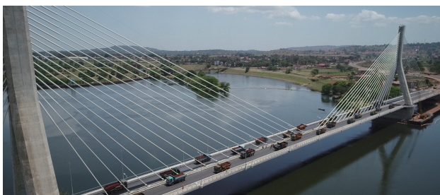
A Fonte da Ponte do Nilo sobre o Corredor Norte construída com o apoio do Japão (Uganda)
