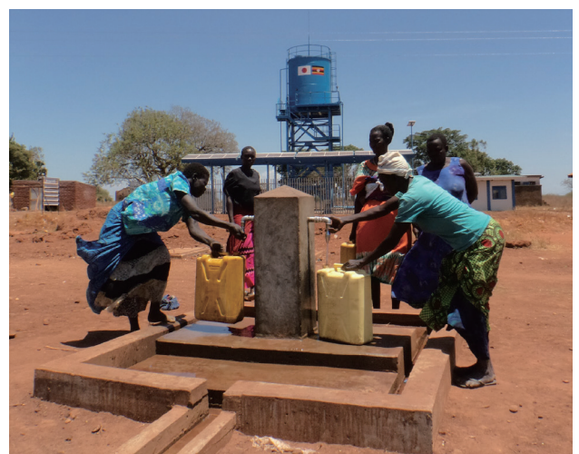
Fonte de água pública instalada por meio do Projecto de Fornecimento e Melhoria da Fonte de Água para os Deslocados Internos na sub-região de Acholi (Uganda)
