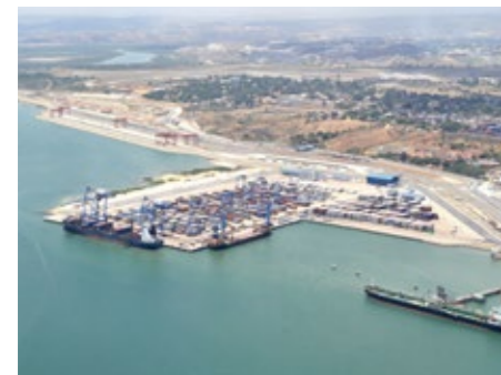
Projet de développement du port de Mombasa (Kenya) Photo: Toyo Construction
