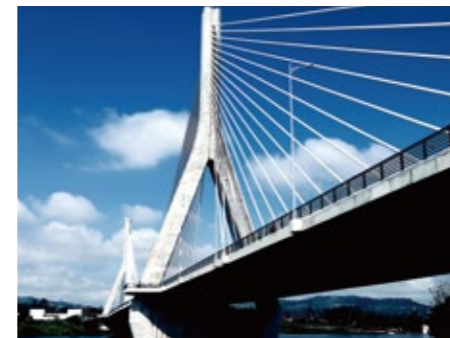
Projet de construction d'un pont sur le Nil (Ouganda) Photo: The Zenitaka Corporation
