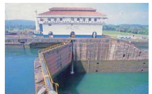
水門で水位を上げ下げして船を通します
