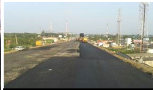
東芝JSW : エンノール港アクセス道路
