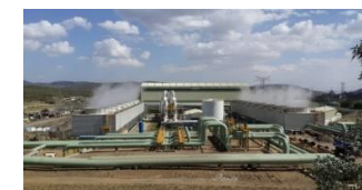
本邦企業も受注し、2015年に完成したオルカリアI地熱発電所4・5号機の様子
