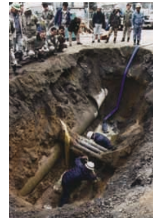
Trabajo de rehabilitación de servicios vitales (cortesía Kobe Shinbun)
