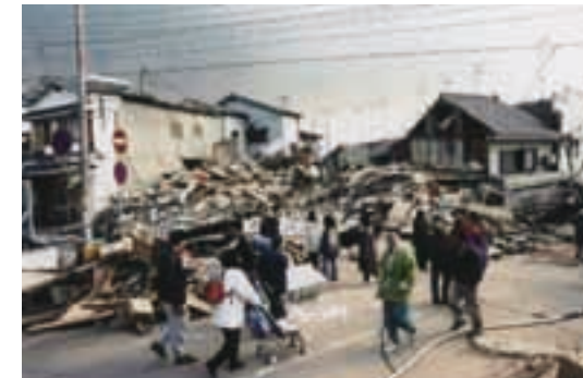
Viviendas privadas derrumbadas (cortesía Kobe Shinbun)
