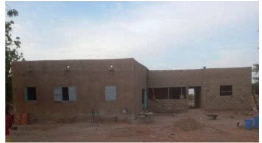
建物右側に診察室が建設されている
